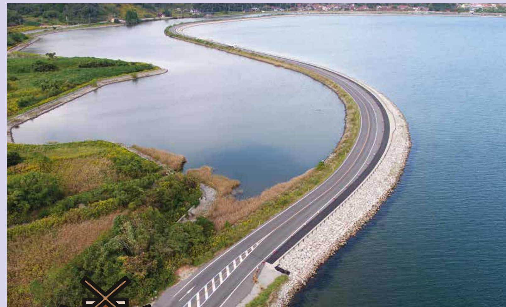
国道431号(松江市)
