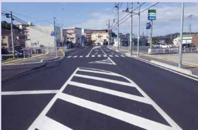
国道432号(松江市)
