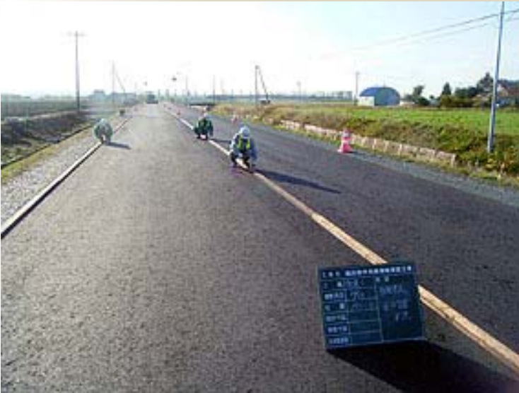
型枠設置状況
