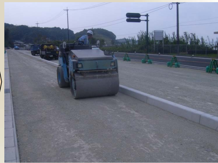
コンバインド式振動ローラによる締固め
