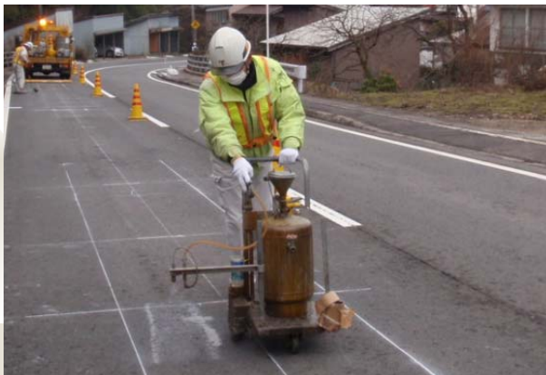
プライマー塗布
