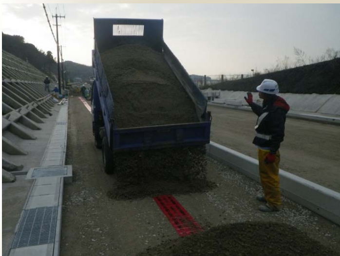
ダンプトラックによる路盤材の搬入
