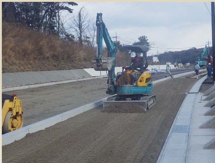
小型バックホウによる路盤材の敷均し
