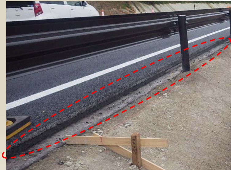
型枠撤去後の状況
