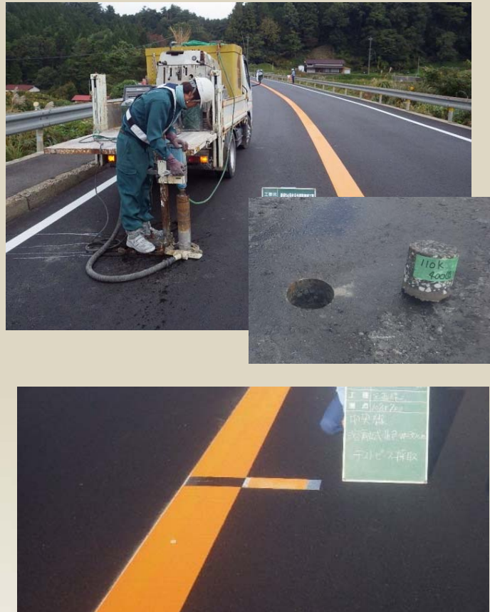
舗装・区画線の厚さ確認
