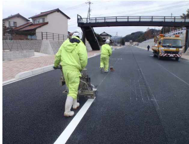
区画線の設置
