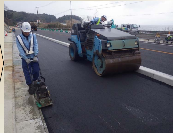
コンバインド式振動ローラによる締固め
