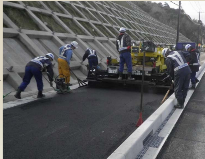
小型Asフィニッシャによる敷均し
