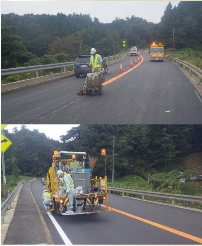
区画線の復旧
