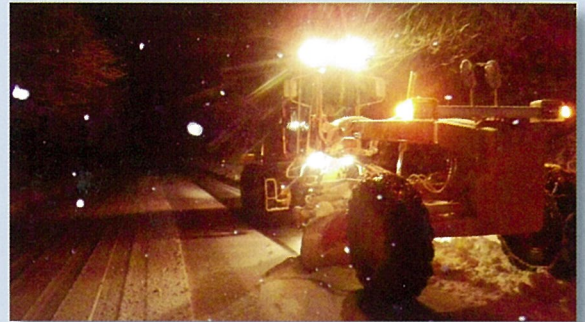
懸命の除雪作業で生活路線を守る
