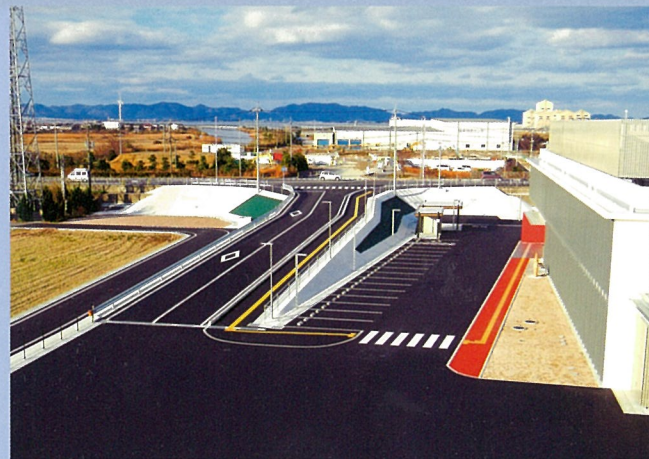
安来市消防新庁舎敷地造成工事
