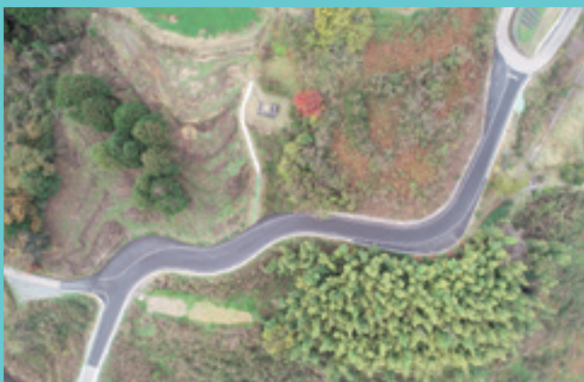
櫛田原(西・東)農道(浜田市)
