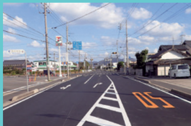
国道431号(出雲市)
