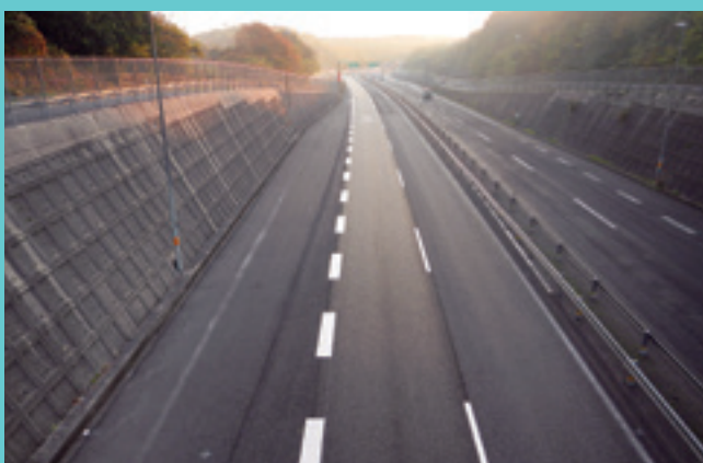
国道9号(松江市)
