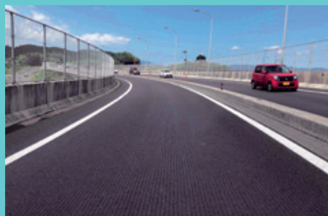
国道9号(松江市)
